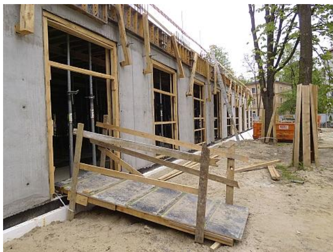
Tak wygląda budowa nowego pawilonu obecnie... źródło: Szpital Wolski
