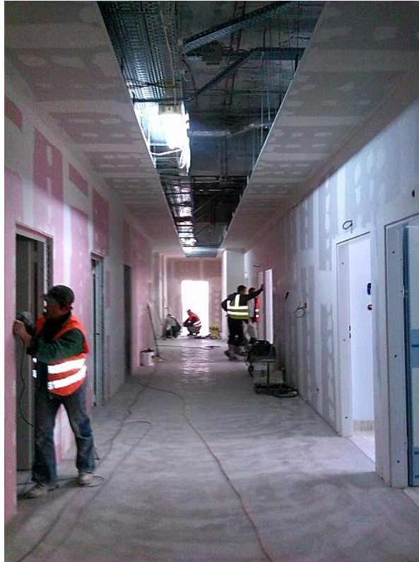
Prace na nowym oddziale geriatryi trwają źródło: Szpital Wolski
