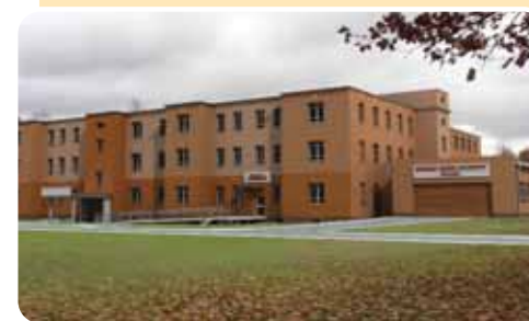
SOR z zewnątrz w przyszłości
